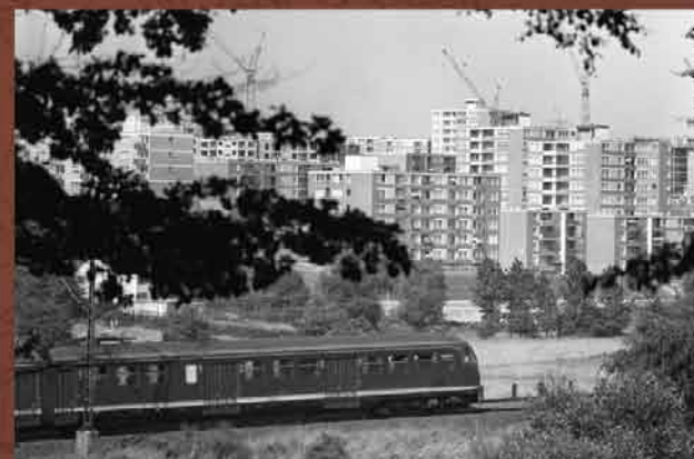
Wohnsiedlung Bergmannsfeld im Bau, 1968
