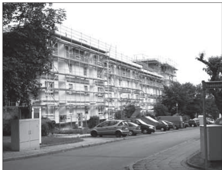
▼ Modernisierung im Bergmannsfeld, 2008. Foto: Christoph Wilmer.
